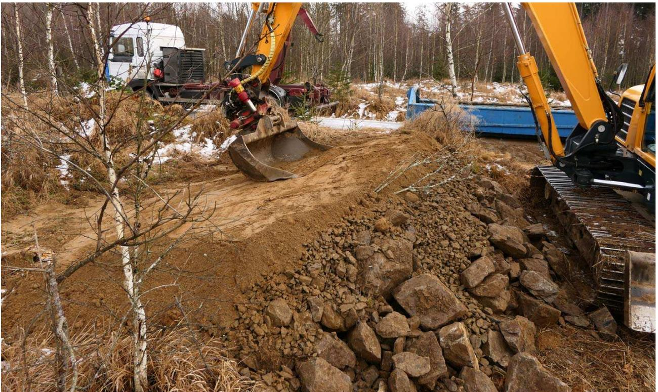
**Abb. 3:** Abschließend wird von Norden her der restliche Aushub und die Grassoden als Deckel aufgebracht. Nach Süden hin bleibt eine Flanke der groben Körnung als Zugang für die Tiere offen.
