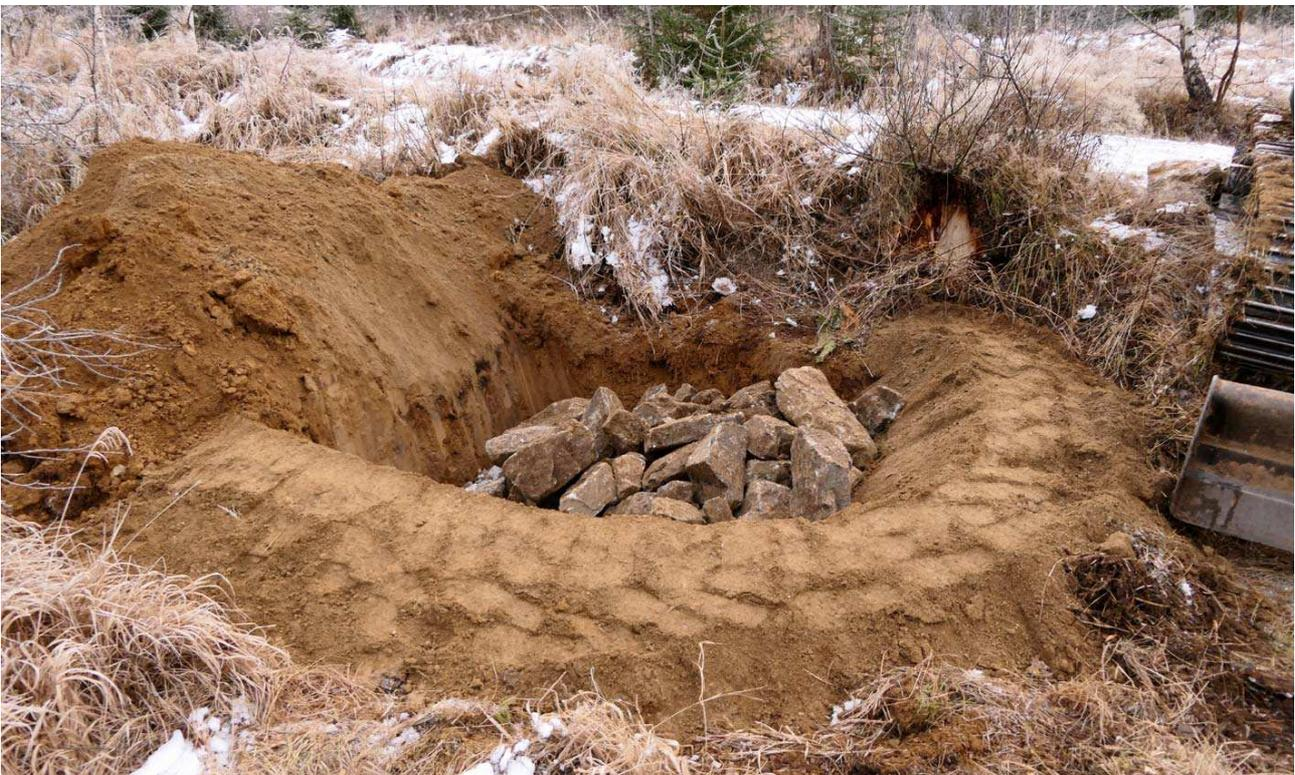
**Abb. 1:** Ein Teil des Aushubs wird als Dammkrone rund um das ca. 1,5 Meter tiefe Loch verwendet. Das Loch dann mit Bruchsteinen grober Körnung verfüllt.
