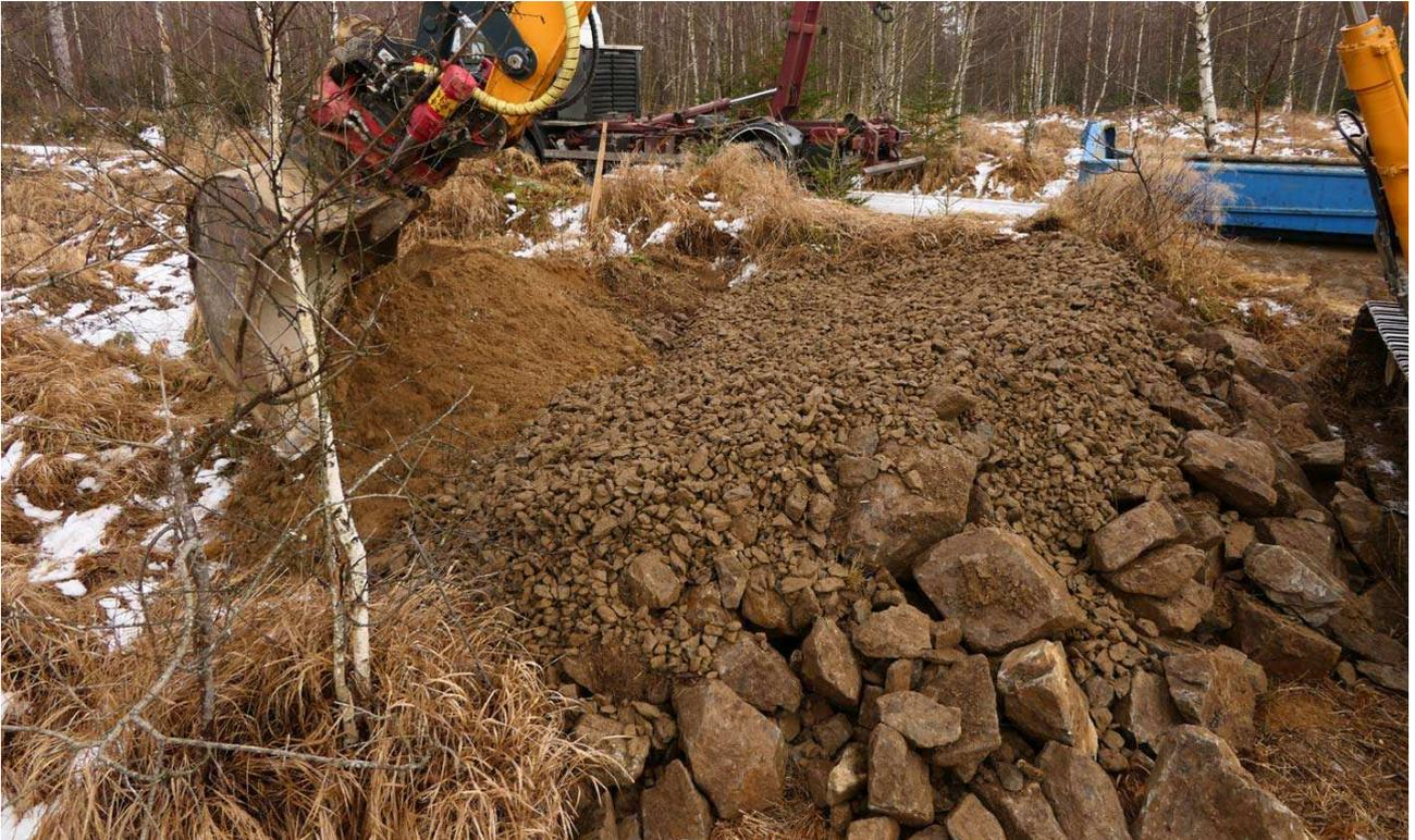
**Abb. 2:** Der Steinhaufen wird oberirdisch erweitert und stufenweise mit kleineren Körnungen überzogen, die als Trennschicht fungieren.
