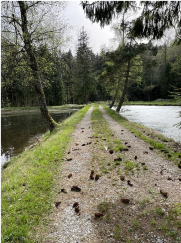
Abbildung 20: Damm zwischen den beiden südlichsten Teichen, Frühjahrsaspekt (April 2024, Blickrichtung Südwest)
