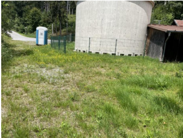
Abbildung 36: Ruderalflur (P432) nach Bauarbeiten, im Hintergrund der ehemalige Faulturm (Juli 2024)
