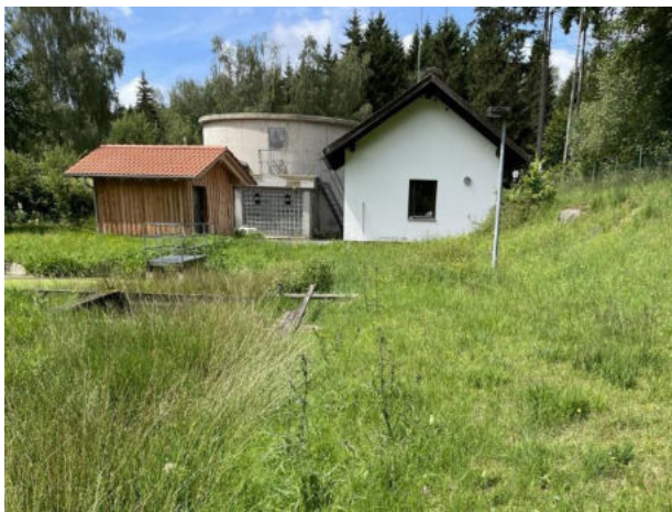
Abbildung 38: Gebäude der Kläranlage mit Holzverkleidung als Fledermaus-Quartierpotenzial (Juli 2024)
