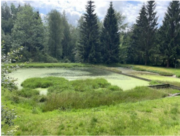
Abbildung 2: Überblick über die Klärbecken nördlich der Straße, im Vordergrund Magerrasen (Juli 2024)
