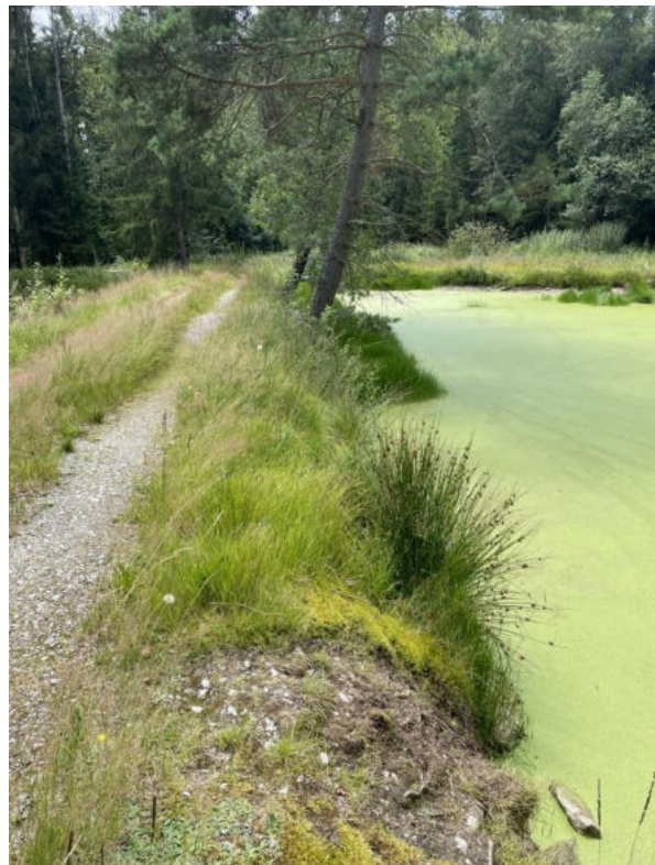
Abbildung 35: Der selbe Damm wie vorige Abb., Blick auf den südwestlichsten Teich, Blickrichtung Südwest
