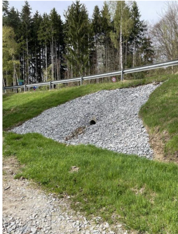
Abbildung 9: Durchlass unter der Straße (Südseite, April 2024, Blickrichtung Nordwest)
