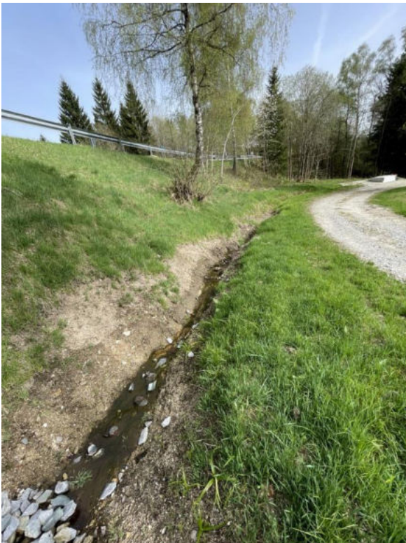
Abbildung 10: Ablauf des Durchlasses von Abb.9 (April 2024, Blickrichtung Ost)
